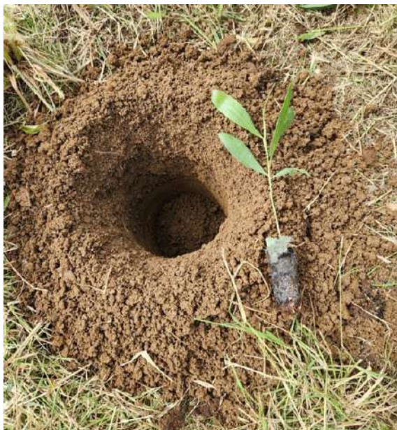
Figura 4. Uso de la hoyadora como opción para sitios donde no se pueda preparar el terreno. Fuente: Olman Murillo, Tecnológico de Costa Rica.
